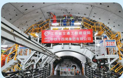
江阴靖江长江隧道右线盾构掘进顺利通过最低点，累计进尺超过 2000 米。图为，施工人员在江阴靖江长江隧道最低点位于水下 82 米处掘进连续不间断作业。江阴靖江长江隧道北接靖江，南连江阴，隧道全长 6445 米，其中江底盾构段长 4952 米。
