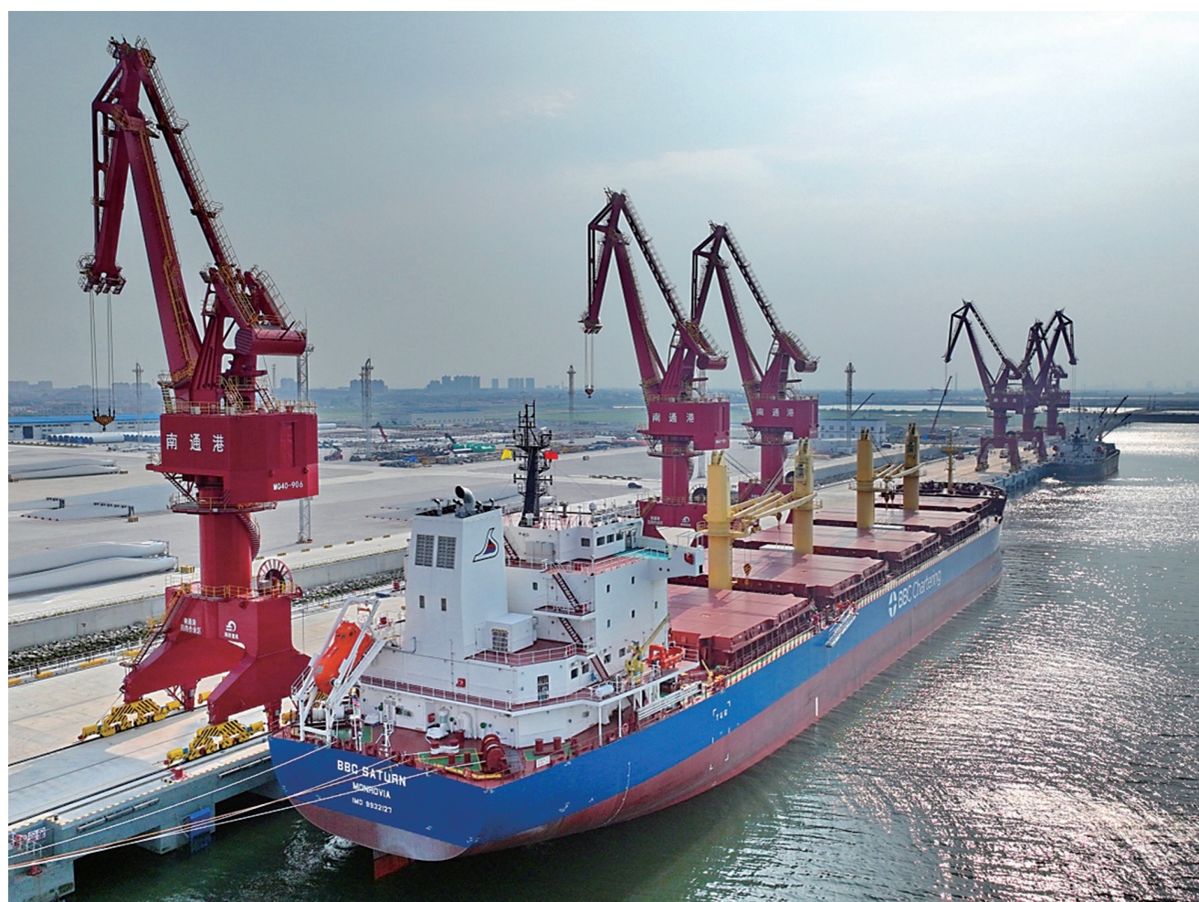
江苏南通通州湾新出海口吕四起步港区，持续开启“开港即繁忙”状态，从第 1 艘至第 38 艘外轮到港仅用了五个多月的时间。图为吕四起步港区 10 万吨级通用码头泊位，刚刚靠泊的美国货船“萨图恩（BBC SATURN）”轮。
