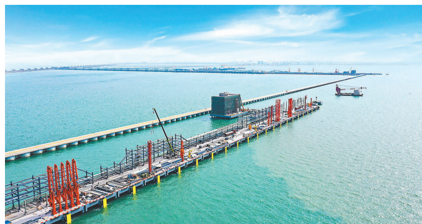
▲连云港市徐圩港区，盛虹石化虹洋港液体散货泊位项目顺利通过竣工验收，这标志着中国首座全面应用装配式工艺的高桩码头即将投入运营。
