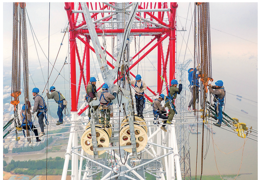
▲世界最高输电铁塔——江苏凤城至梅里500千伏长江大跨越工程现场，国网江苏电力施工人员正在百米高空跨越长江架设导线。该工程建成后，可满足约800万户家庭的日常用电需求，有效提升长江两岸电网互联互通、互补互济能力。
