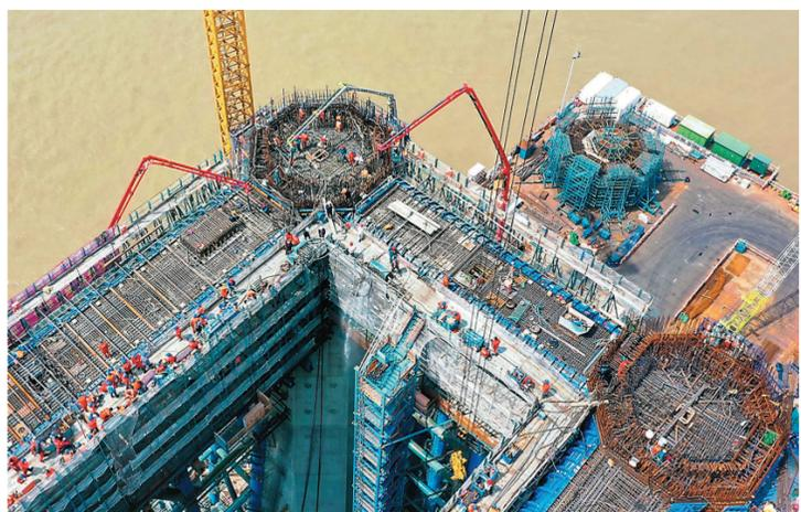
4月4日，在建世界最大跨度公铁两用斜拉桥——常泰长江大桥北主塔下横梁首个“L”型区域浇筑完成，标志着大桥两座主塔均进入下横梁浇筑施工阶段。图为中交二航局工人在进行浇筑施工（无人机照片）。 汤德宏 刘洋森 摄
