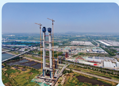
中铁大桥局集团有限公司承建的南京市仙新路过江通道北主塔总高度 263.8 米，目前已施工至 242 米。项目部严格做好疫情防控各项工作，工地实施封闭管理，作业人员两点一线上下班，目前现场各项施工正在稳步有序推进，预计 5 月 20 日主塔封顶。图为 4 月 21 日拍摄的北主塔施工作业现场。陈俨摄
