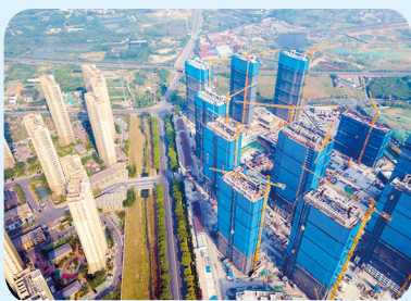
4 月 20 日，位于南京化学工业园区的小汤经济适用住房项目正在加紧施工，预计今年年底竣工，明年交付使用。届时，葛塘、大厂、长芦等街道 2000 多户拆迁居民将乔迁新居。吴俊摄
