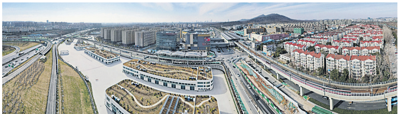
▲南京马群综合换乘中心及公交停车场建筑基本建成，外部幕墙和内部砌筑施工结束，正在进行建筑装饰和周边道路铺设。地铁2号线站台与S6号线投入使用，将有效缓解交通压力。
