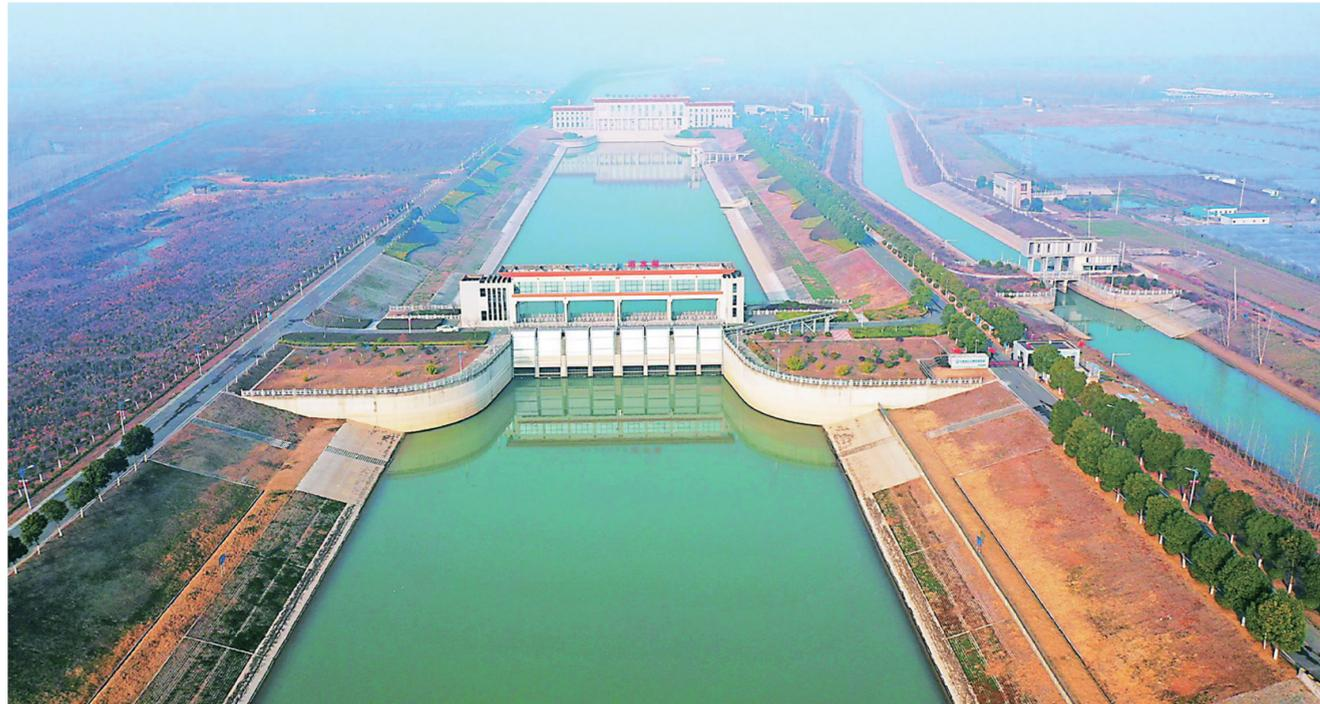
↑南水北調東線第三梯級泵站，洪澤泵站開啓梯級第八個年度向省外調水任務——將一江清水源源不斷通過洪澤湖、駱馬湖調蓄，送到蘇魯邊境。南水北調東線江蘇境內工程今年11月首次「開機調水」。三台泵組，每秒向洪澤湖補水108立方米。
