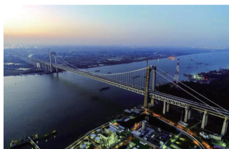
作为连淮扬镇铁路关键控制性工程的五峰山长江大桥，是目前世界上跨度最大、运行速度最快、运行荷载最重的公铁两用悬索桥。五峰山长江大桥全长 6.4 公里，主跨采用 1092 米钢桁梁悬索桥横跨长江航道，上层公路为八车道高速公路，下层为四线高速铁路。图为镇江五峰山长江大桥航拍
