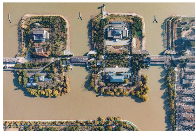
▲12月17日，航拍江都水利枢纽冬日景致。江都水利枢纽位于江苏省扬州市境内京杭大运河、新通扬运河和淮河入江水道交汇处，南溯长江、北连淮河，是南水北调东线工程的源头，也是目前中国规模最大的电力排灌工程、亚洲最大的泵站枢纽。 洪波摄
