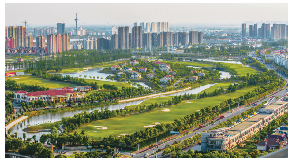
城市概况（太仓是一座长江经济带和沿海开放带交汇点上的滨江港口之城）
